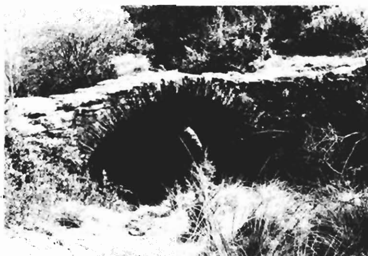
Fig. 26. Puente sobre el barranco de El Mon.
