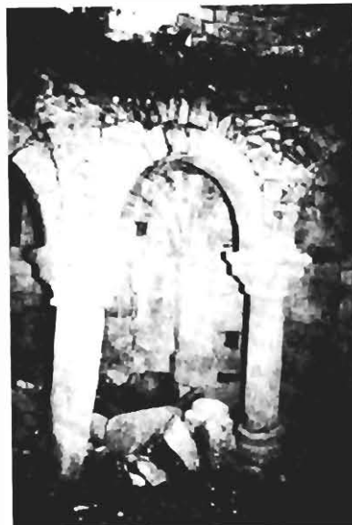
Fig. 9. Vista parcial de la cripta.
